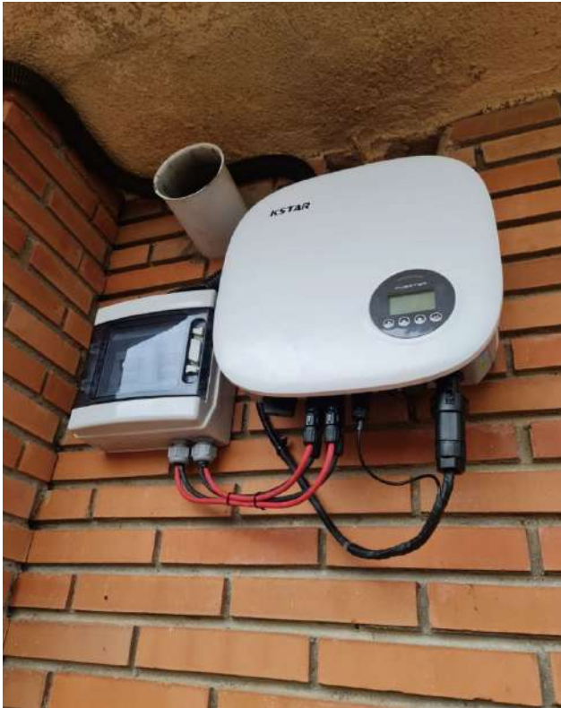
08 Residentieel Zonne-energieproject in Brazilië
